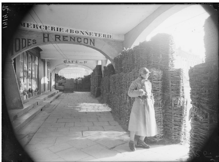
8 / Référence : SPA 111 R 4141 Pont-à-Mousson, Meurthe-et-Moselle, les gabions protégeant la place Duroc. 17/02/1918, opérateur Edmond Famechon.
